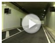
Südwest-Tunnel des Kö-Bogens eröffnet »
